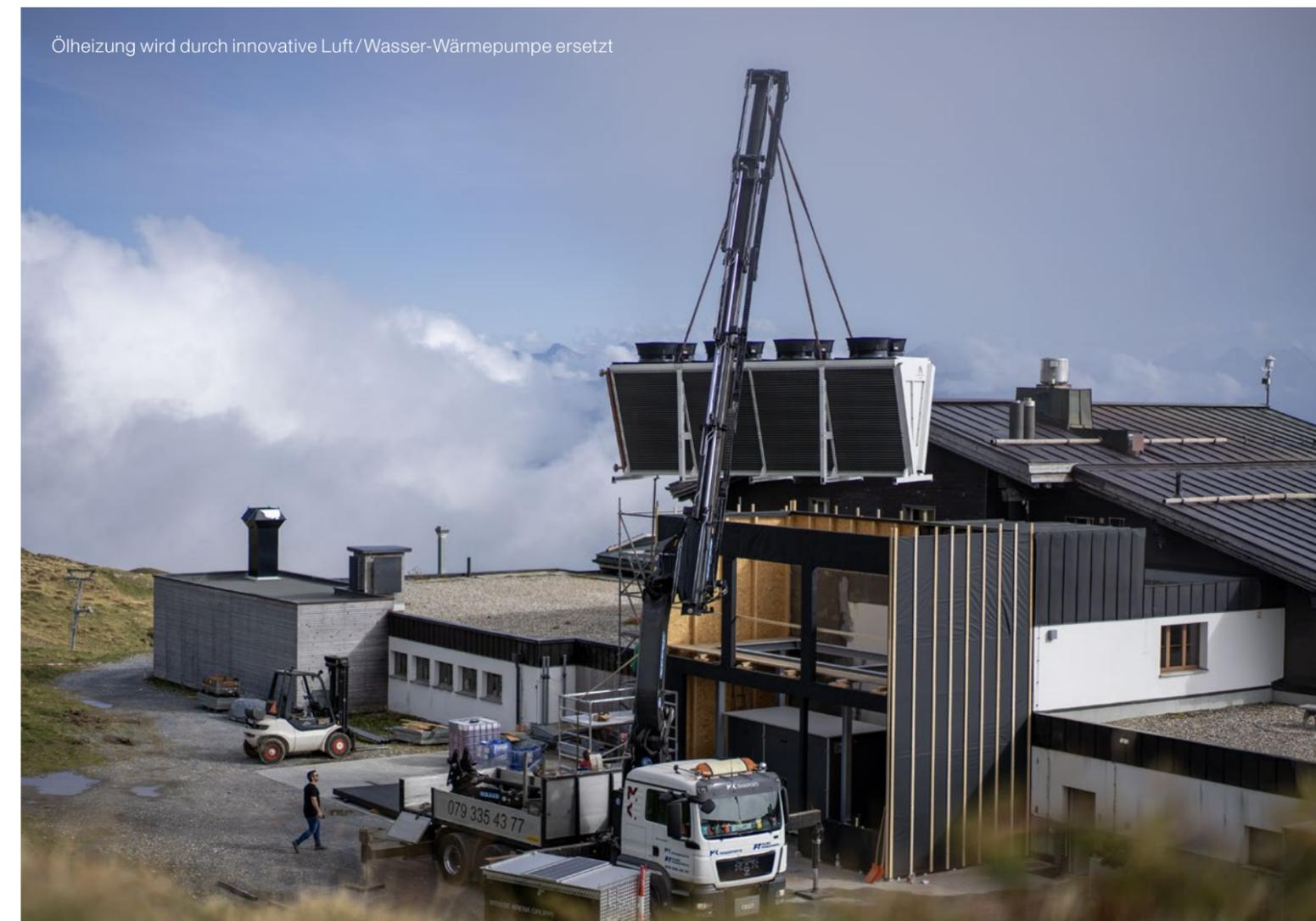
Ölheizung wird durch innovative Luft/Wasser-Wärmepumpe ersetzt
